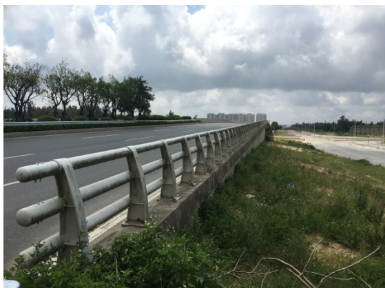
桥梁绿化现状 (1)
