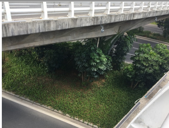
桥梁绿化现状 (4)
