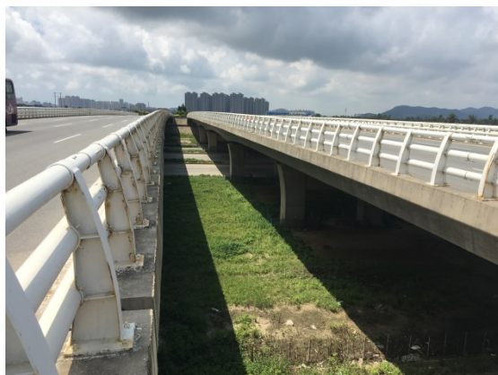
桥梁绿化现状 (2)
