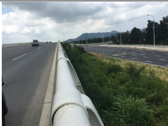
桥梁绿化现状 (3)
