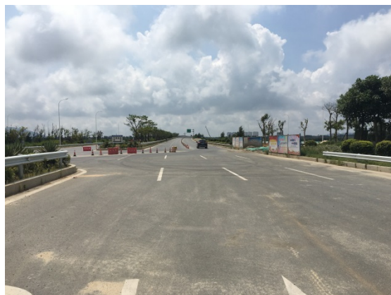
项目终点现状 (2)
