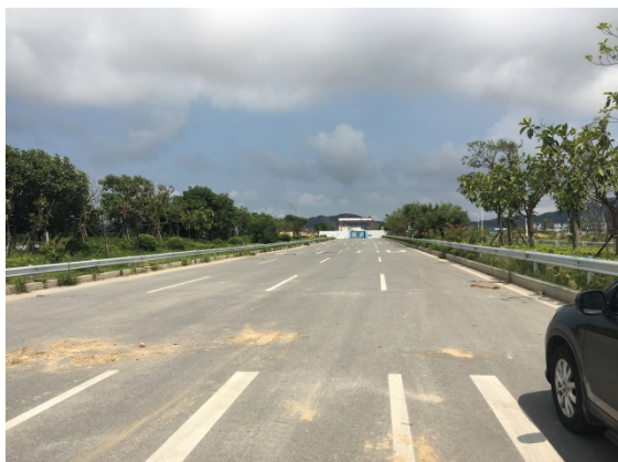
项目终点现状 (1)
